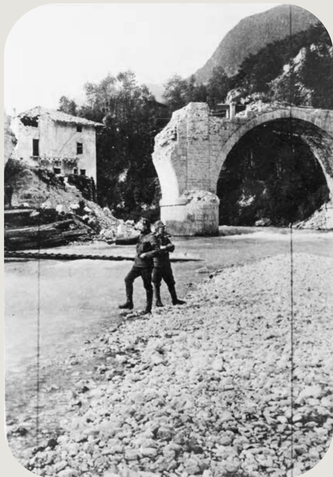
Porušen most čez Tolminko pri Tolminu
