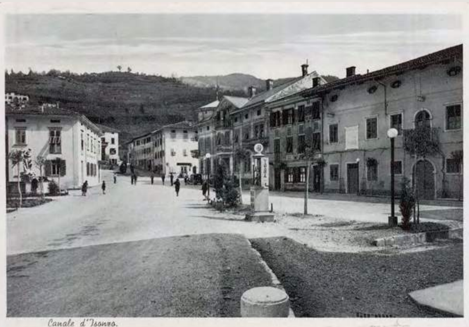
Kanal – la piazza centrale dopo la ricostruzione (Fonte: PANG)
