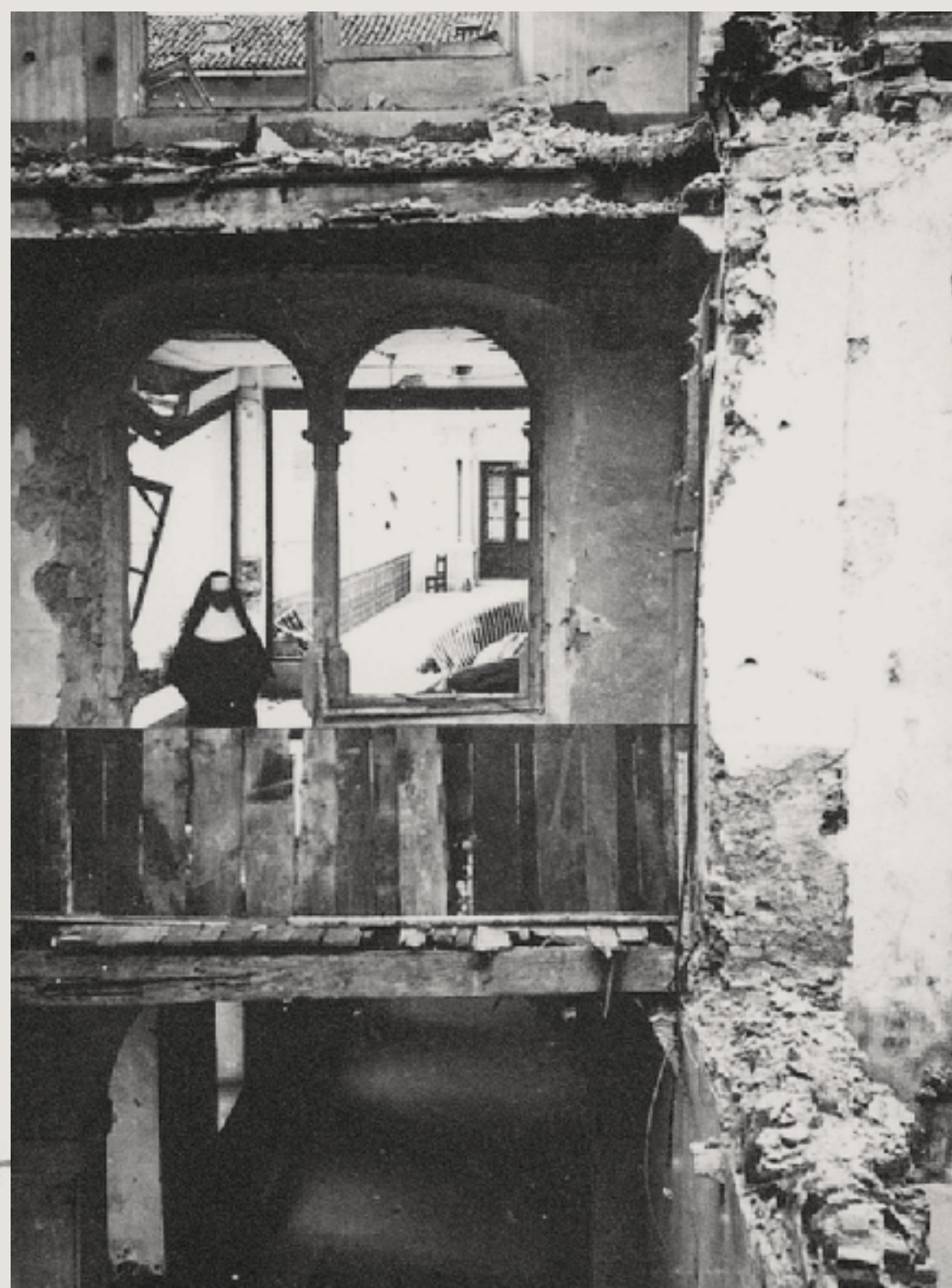
Iconvento sul Monte Santo fortemente danneggiato
