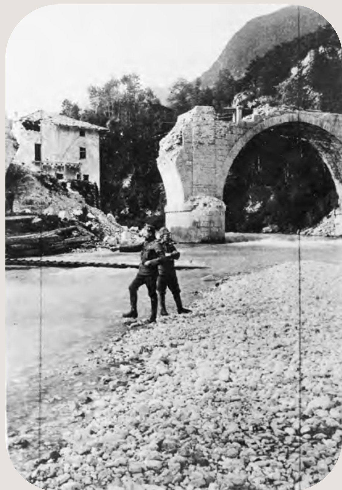
Tolmin, il ponte distrutto sulla Tolminka
