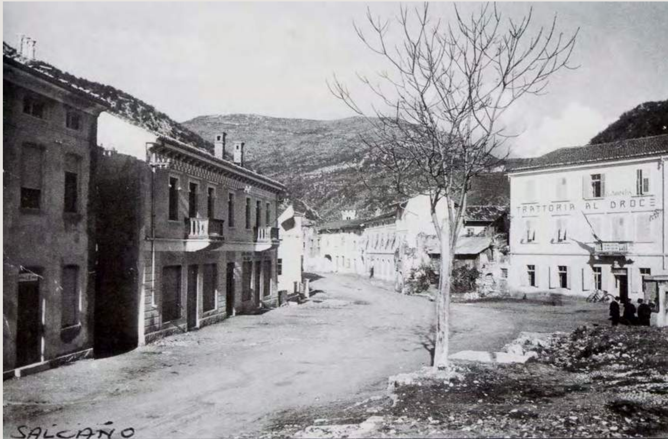
Solkan, la ricostruzione parziale della piazza dopo la guerra (Fonte: Goriški muzej)
