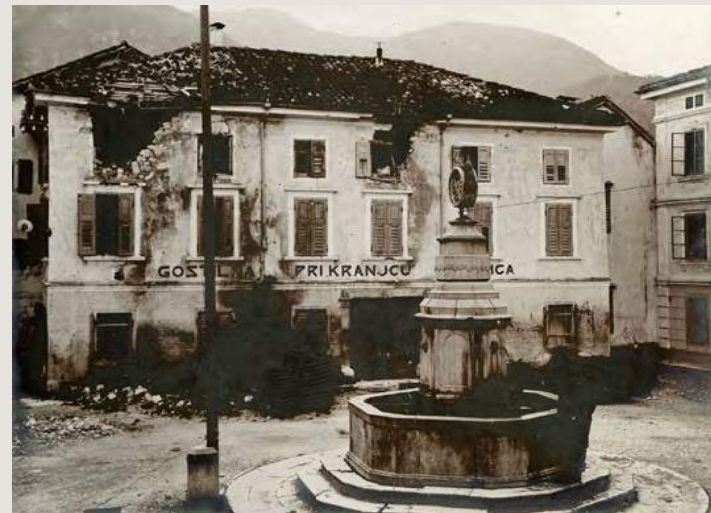
Tolmin, la piazza centrale con la fontana e con le rovine della trattoria Kranjec
